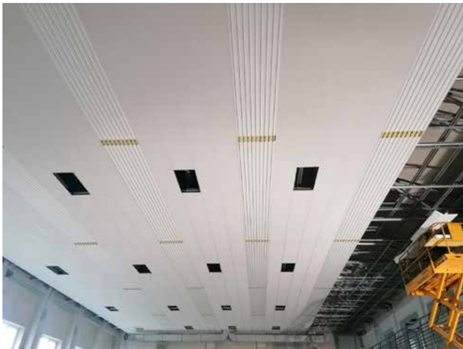
Particolare della realizzazione dei controsoffitti delle palestre
